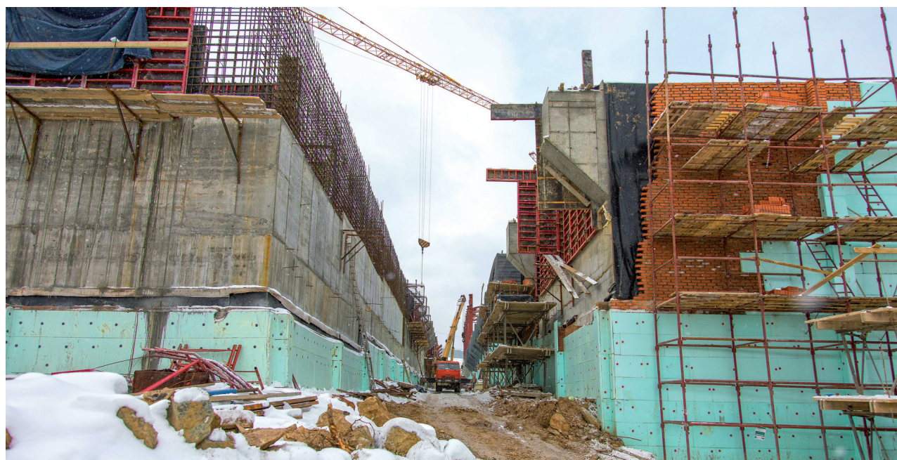
■ Строительство второй очереди хранилища в Новоуральске.
